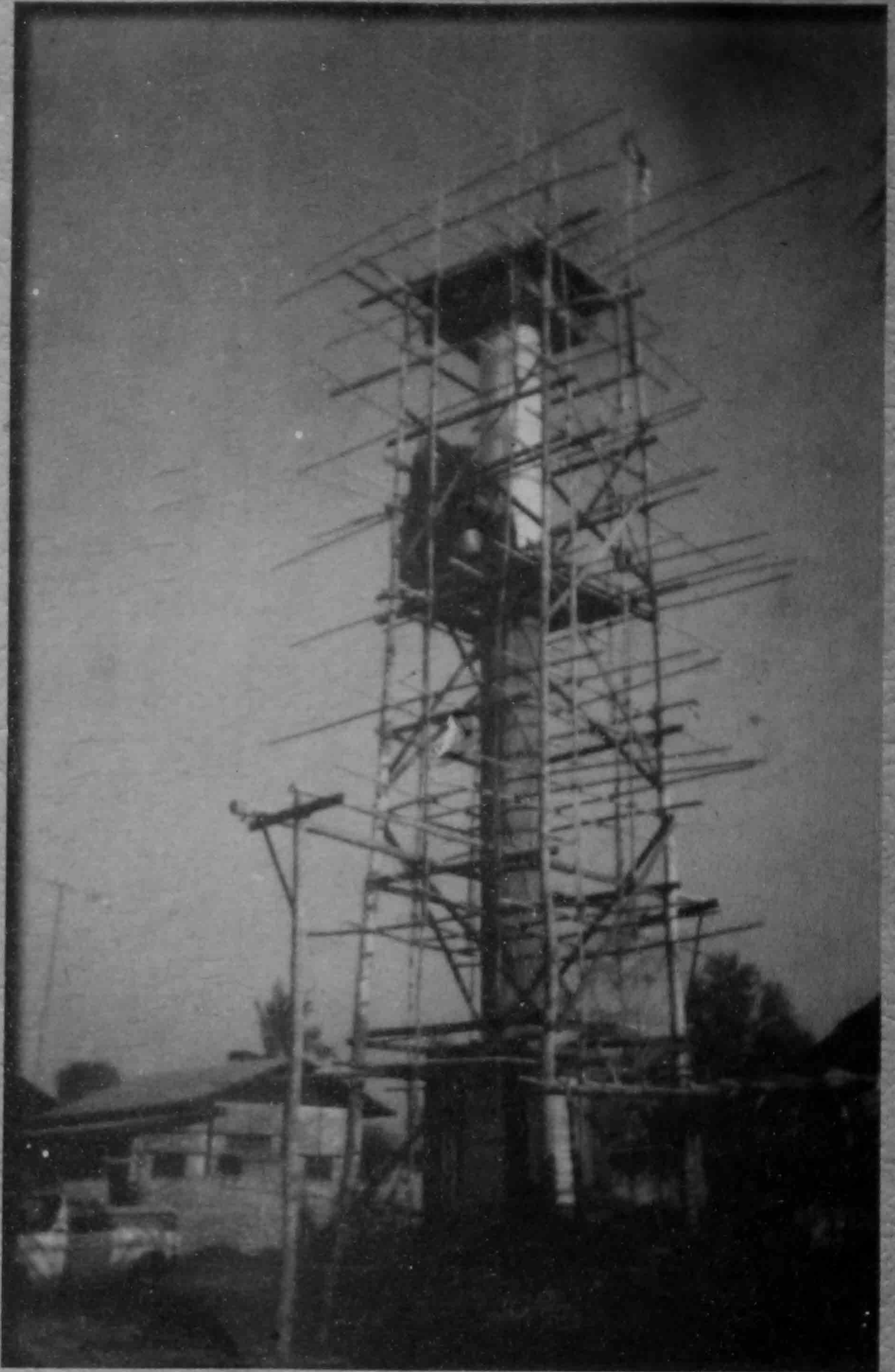
တည်ဆောက်ဆဲ ဂေယျဇမ် ရွှေချက်သို့ တံခွန်တိုင်
